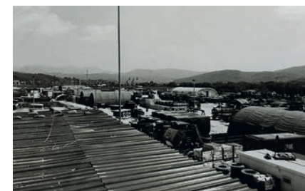
Overzicht Base Novi Trafnik
